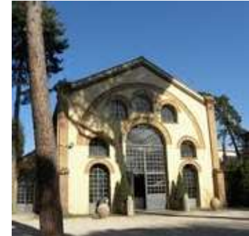
SOLAR PV SKYLIGHT – ARANCIERA S. SISTO ROME
