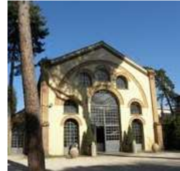
SOLAR PV SKYLIGHT – ARANCIERA S. SISTO ROME
