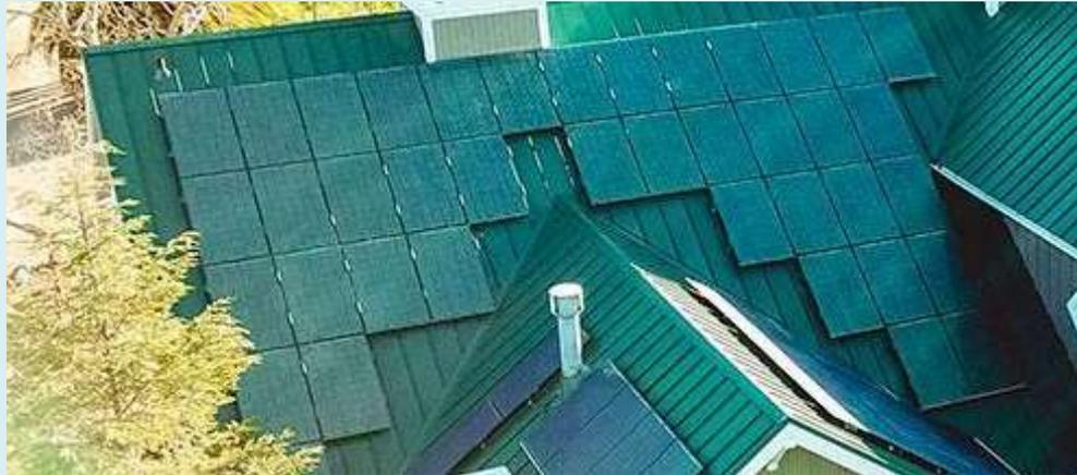
Figura 3.39 Esempio di sistemi BAPV appoggiati sulla copertura ma non integrati - fonte: [www.onyxsolar.com](http://www.onyxsolar.com)
