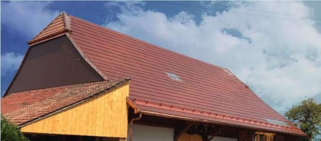
*Figura 3.10: Esempio di modulo fotovoltaico in copertura con colorazione che si integra al contesto esistente – fonte: [www.besmartproject.eu](http://www.besmartproject.eu)*
