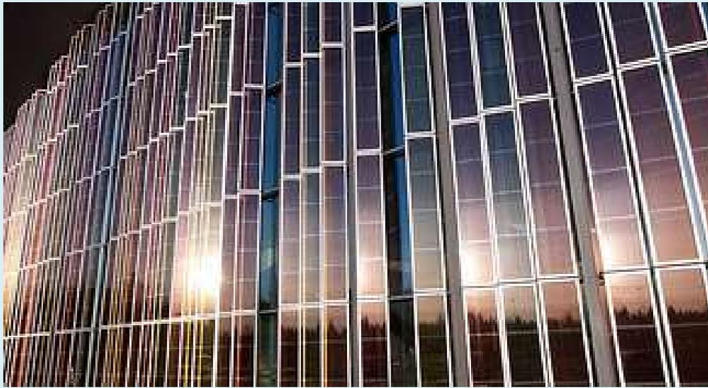
*Figura 3.24 Esempio di BIPV riflettente in facciata – fonte: [www.igsmag.com](http://www.igsmag.com)*
