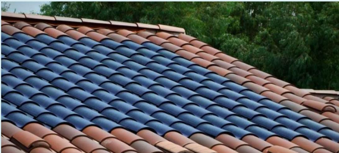
*Figura 3.11: Esempio di modulo fotovoltaico in copertura con colorazione che non si integra al contesto esistente – fonte: @Bête spatio-temporelle – Own work*
