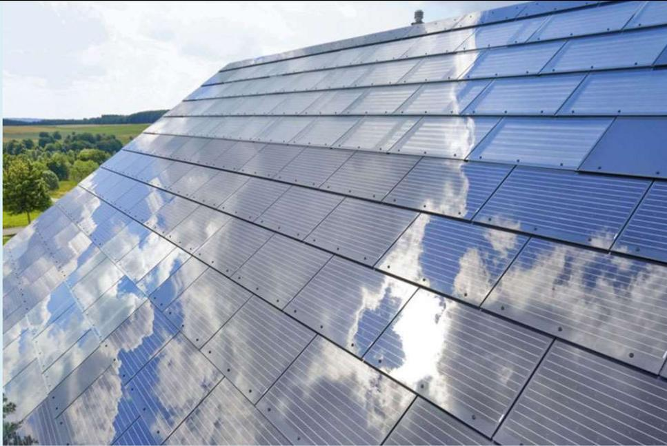
Figura 3.14 Esempio di BIPV in copertura con texture lucida – fonte: [www.seelectricalservicesltd.com](http://www.seelectricalservicesltd.com)
