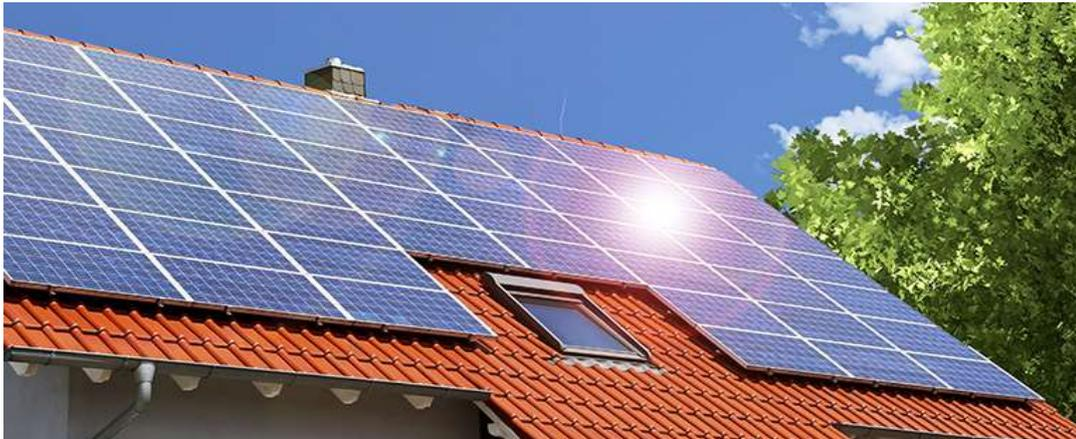
Figura 3.22 Esempio di BAPV in copertura con problemi di riflessione – fonte: [www.gwhsolar.com](http://www.gwhsolar.com)
