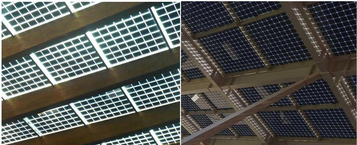
Figura 3.27 Sistemi BIPV in silicio cristallino con celle diversamente distanziate - fonte: [www.onyx solar.com](http://www.onyx solar.com)
