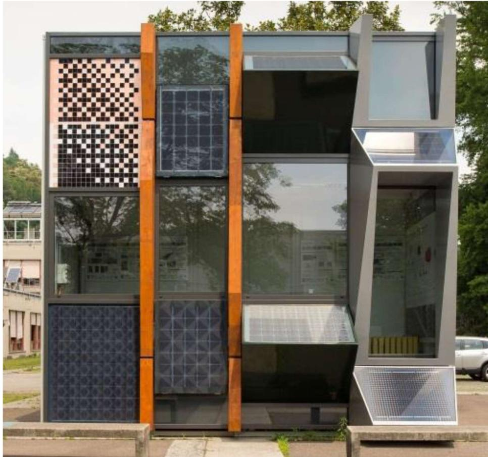
*Figura 3.15 Un mock-up di facciata al campus di Treviso della SUPSI mostra le varie possibilità di progettare moduli in diverse tipologie di facciata. [31]*
