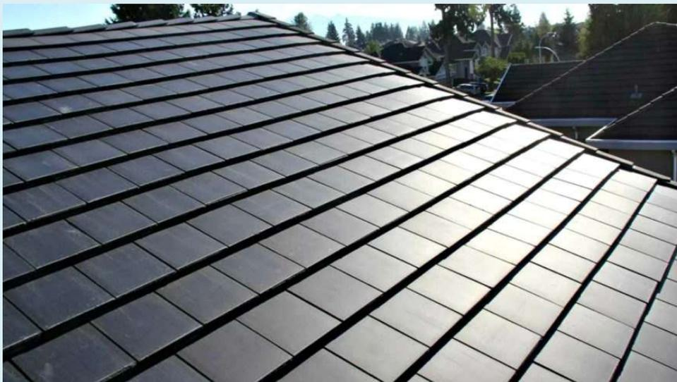
*Figura 3.13 Esempio di BIPV in copertura con texture opaca – fonte: [www.inhabitat.com](http://www.inhabitat.com)*
