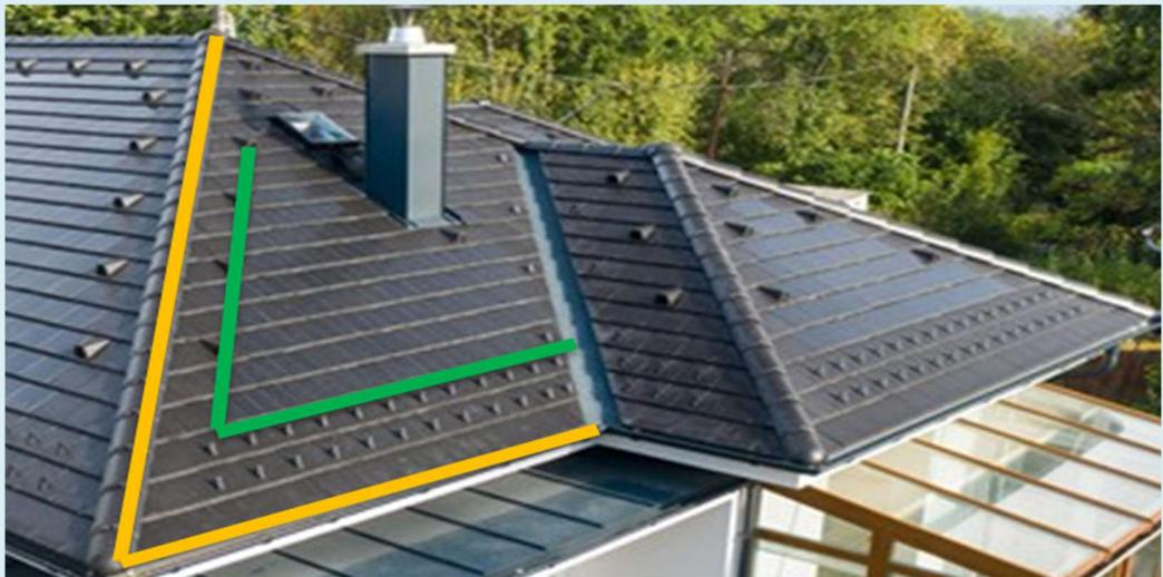
Figura 3.38 Esempio di sistemi BIPV che seguono le linee della copertura esistente fonte: [www.buildwithrise.com](http://www.buildwithrise.com)
