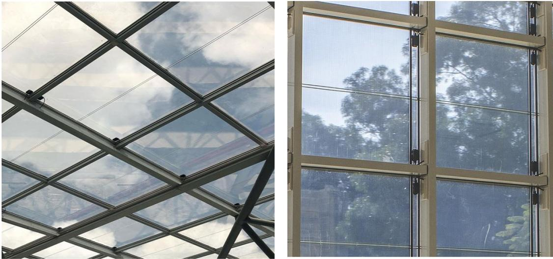
Figura 3.29 Sistemi BIPV in silicio amorfo con trasparenza omogenea - fonte: [www.onyxsolar.com](http://www.onyxsolar.com)
