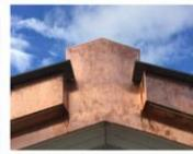
Il fronte originale del tetto ha dovuto essere riprogettato a causa dell'aumento dello spessore dell'isolamento del tetto.
