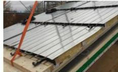
Montaggio degli elementi solari BS2 FVT sul tetto esistente
