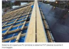
Sistema di copertura PV (binari) e sistema FVT (binari) durante il montaggio
