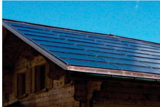
La superficie del tetto comprende anche un impianto solare termico di 9,2 mq che produce 4'968 kWh/a, ovvero il 37% dell'energia totale prodotta dalla copertura.
