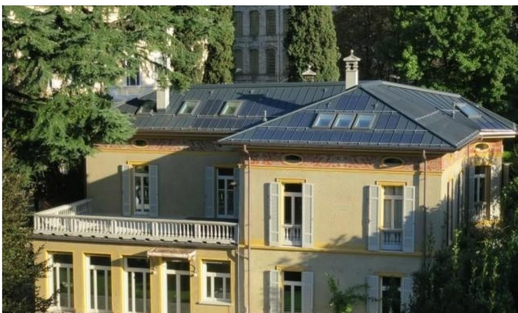
Figura 13- Vista aerea della copertura in cui si nota l'integrazione del sistema fotovoltaico - fonte [BiPV.eurac.edu](http://BiPV.eurac.edu)
