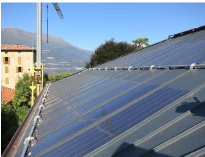
*Figura 15 – Vista del sistema fotovoltaico integrato alla copertura- - fonte BiPV.eurac.edu*
