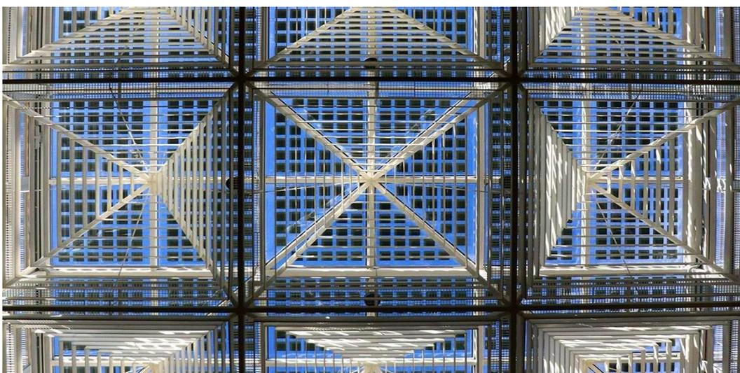
Figura 3 – Dettaglio della struttura del lucernario e dei vetri fotovoltaici – fonte: [www.onyxsolar.com](http://www.onyxsolar.com)
