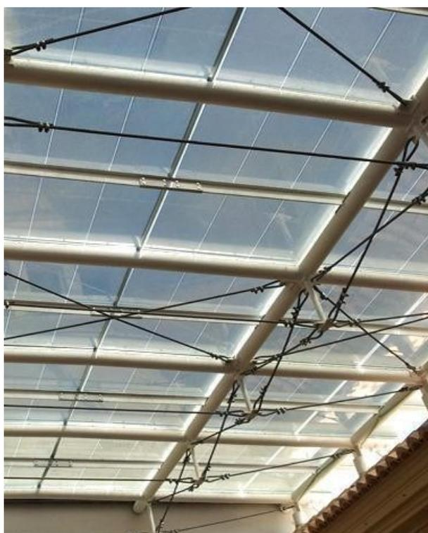
*Figura 9 – Dettaglio del lucernario e dei vetri fotovoltaici– fonte: [www.onyxsolar.com](http://www.onyxsolar.com)*
