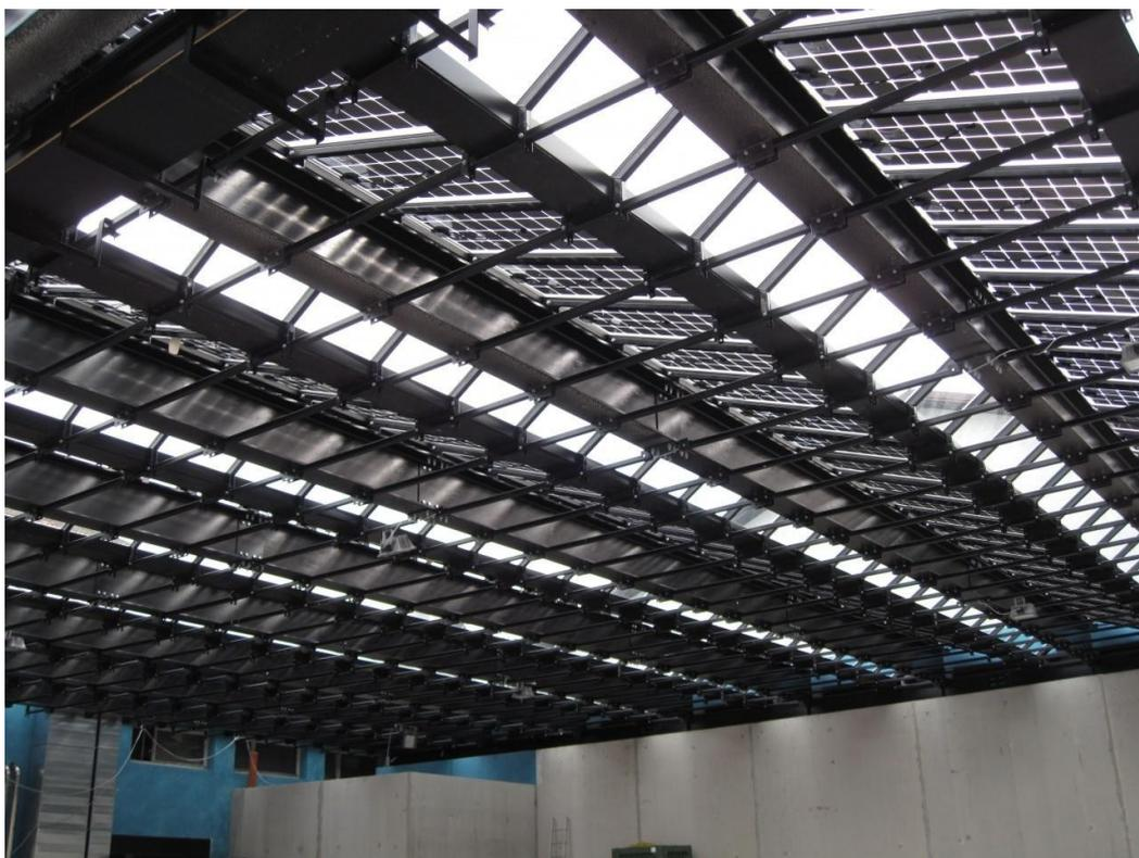
*Figura 25 – Dettaglio della copertura e del lucernario con le vetrate fotovoltaiche -fonte [www.BiPV.eurac.edu](http://www.BiPV.eurac.edu) -*
