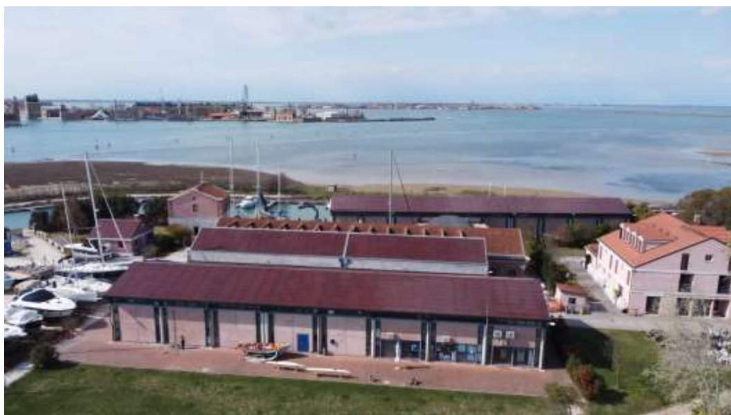
Figura 9 Gli edifici con copertura fotovoltaica (GruppoSTG/VDV srl).
