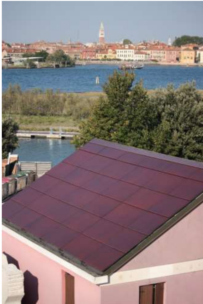
Figura 5 Sistema fotovoltaico integrato sull'Isola della Certosa - Venezia (@GruppoSTG)
