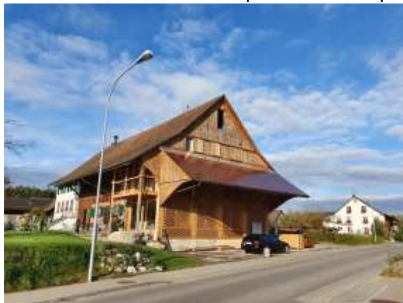
Figura 2 Edificio Rurale, Seegräben – Svizzera (@Sunage)
