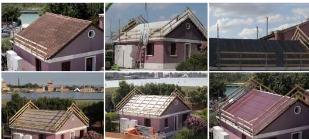
Figura 10 Le fasi di montaggio della copertura fotovoltaica (GruppoSTG/VDV srl).
